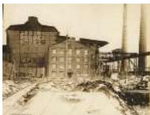
На Нижне-Выксунском заводе мартеновское производство было освоено в 1892 году, а в 1984 был построен специализированный мартеновский цех, с печью ёмкостью 12 тонн, с ручной завалкой шихты, возведены газогенераторная станция и мазутная. Первым начальником цеха работал Альберт Генрихович Клеф. Сталь и стальные изделия имели более широкий спрос, чем железо, что дало возможность за
