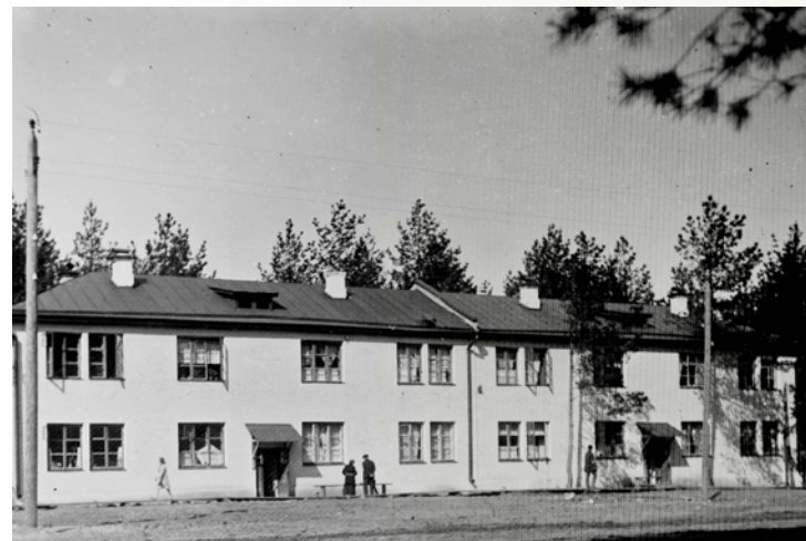
Двухэтажный дом для специалистов завода ДРО на ул. Кр. Зори. 1950–60 гг.
