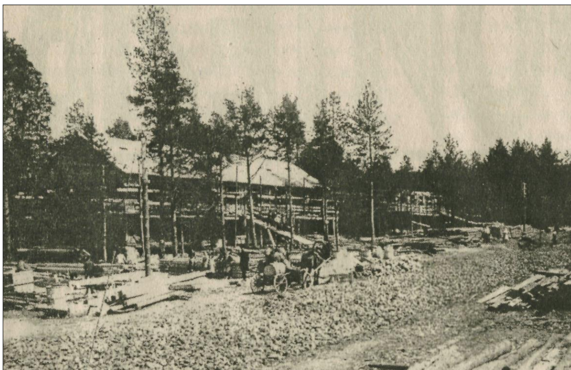
Строительство двухэтажного дома в начале улицы Красные Зори напротив бревенчатого одноэтажного магазина «шестнадцатый» с вывеской «Универмаг».
