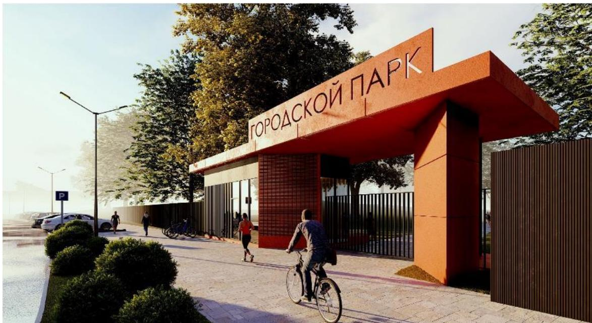
Объект представляет собой портал с воротами, рассчитанный также на проезд спецтранспорта, и небольшой теплый павильон ТИЦ. Конструкции павильона - металлический каркас, композитные панели, структурное остекление. Объект встроен в ограждение парка.
